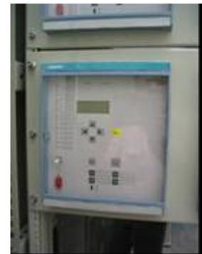
Vista de Tablero con la Unidad Central instalada en la Sala de Control de la S.E. Campo Armiño
