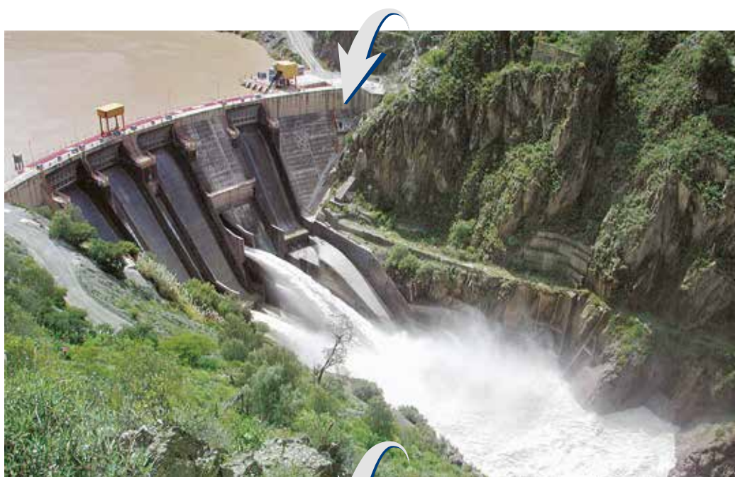
Presa Tablachaca / Tablachaca Dam
