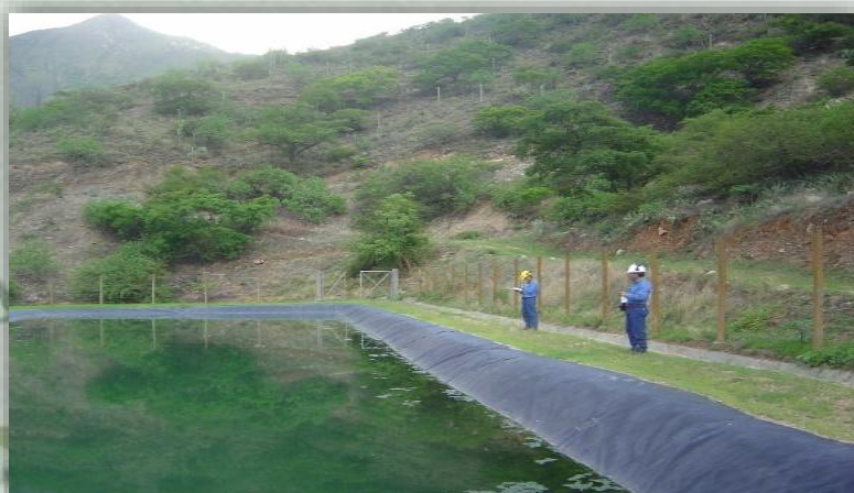
Laguna de oxidación N° 1, donde su mantenimiento y limpieza es constante.
