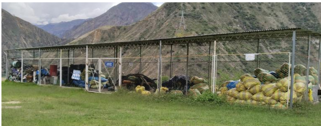
Almacén de residuos peligrosos
