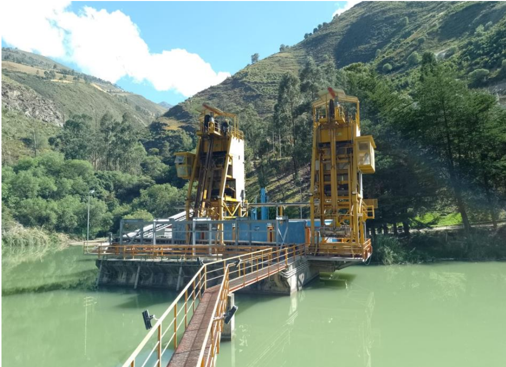
Fig. N° 01 – Sistema Limpiarrejas de Obra de toma – Presa Tablachaca
