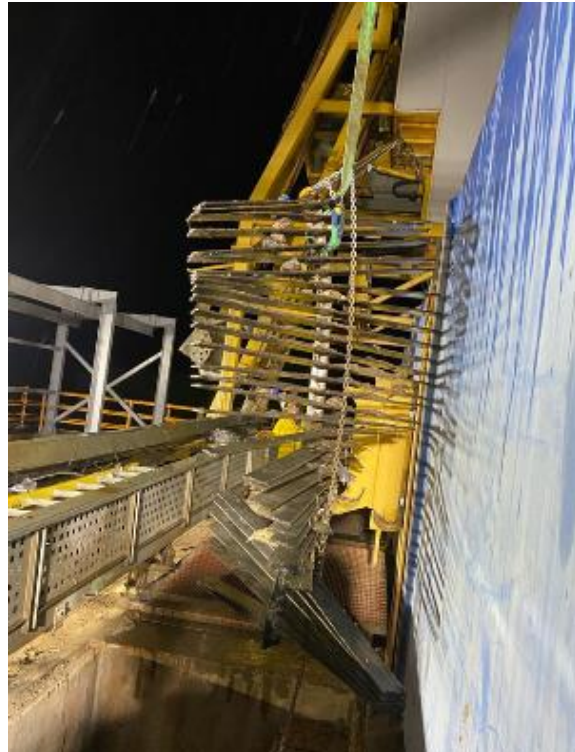
Fig. N° 03 – Partes de la reja extraída del fondo de la nave D – Obra de Toma en marzo 2024.
