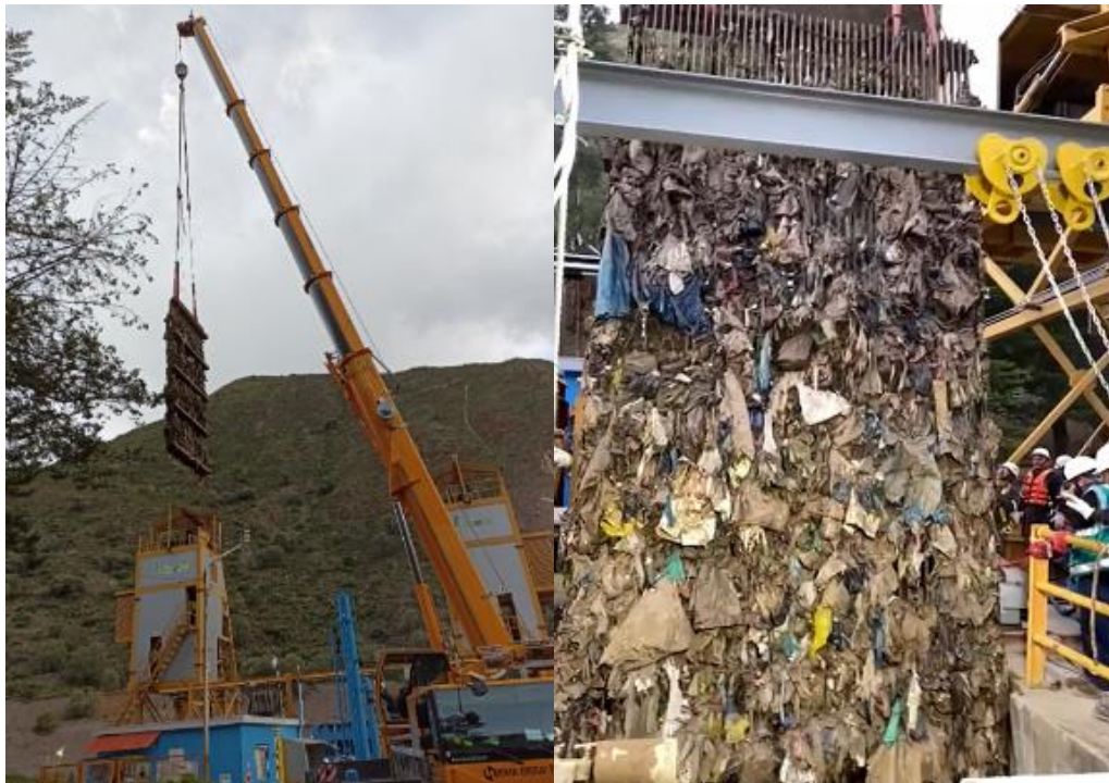
Fig. N° 01 – Sistema Limpiarrejas de Obra de toma – Presa Tablachaca
