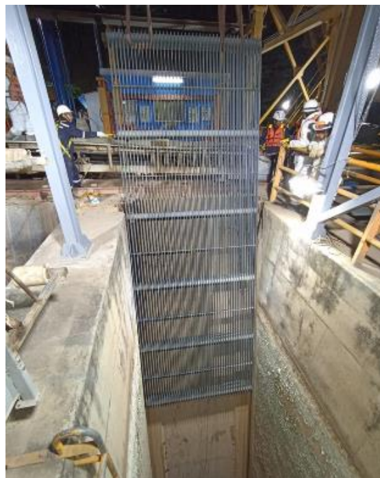
Fig. N° 03 – Partes de la reja extraída del fondo de la nave D – Obra de Toma en marzo 2024.
